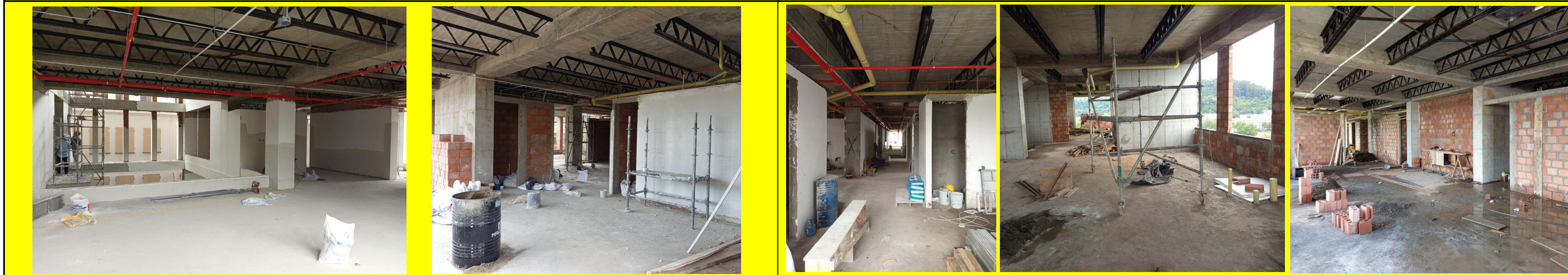
Repellos, estucos, red hidrosanitaria, red contra incendios. 6to piso.
