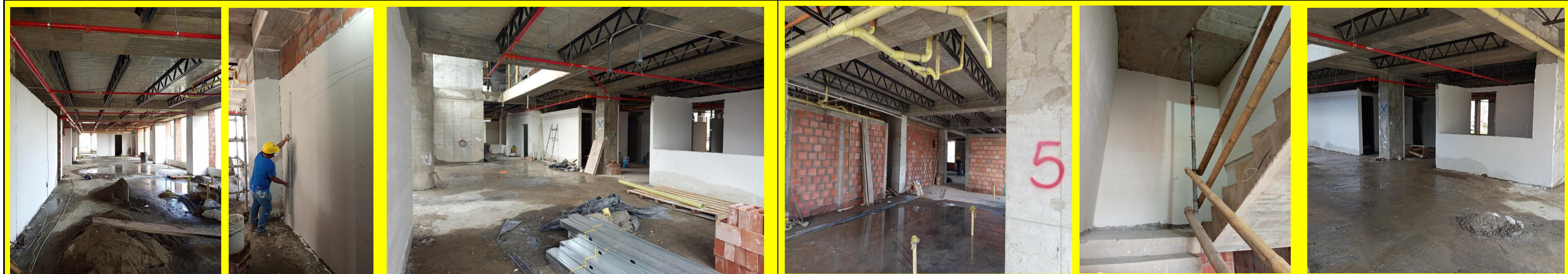
Repellos, estucos, red hidrosanitaria, red contra incendios. 4to piso.
