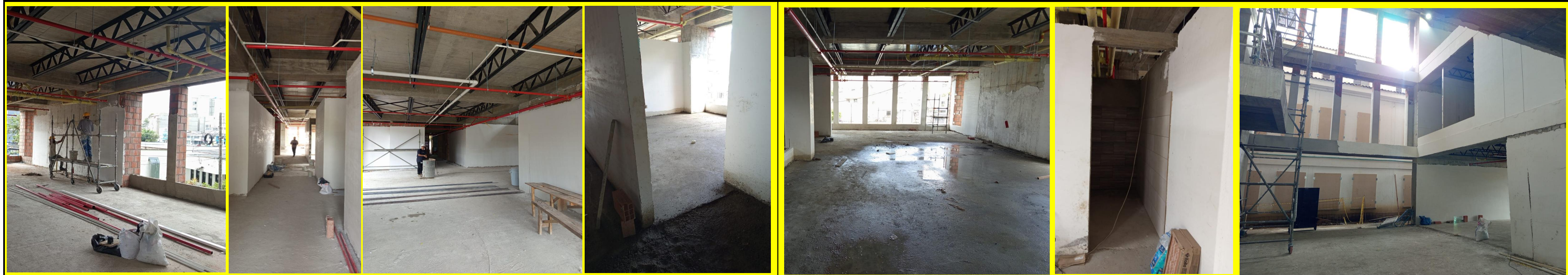
Repellos, estucos, red hidrosanitaria, red contra incendios. 1er y 2do piso.
