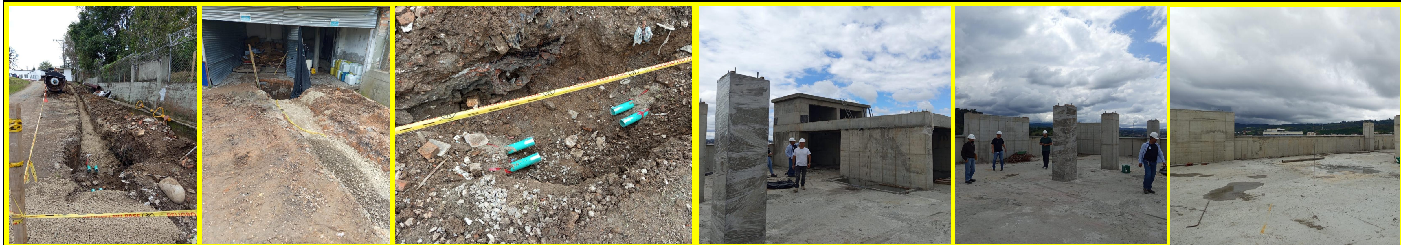
Inicio de obras de acometida eléctrica a media tensión del operador CEO
