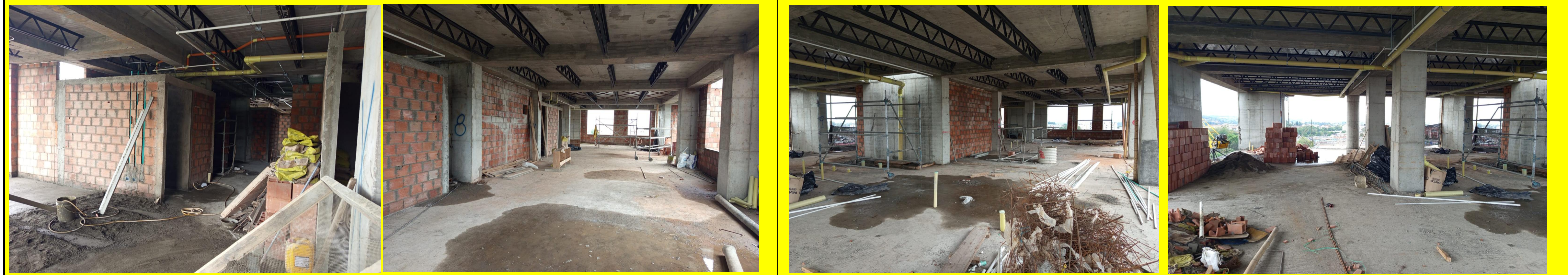
Repellos, red hidrosanitaria. 8vo piso.
