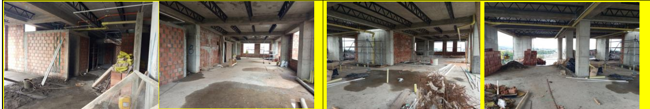
Repellos, red hidrosanitaria. 8vo piso.
