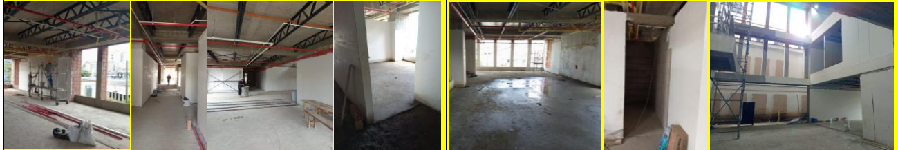
Repellos, estucos, red hidrosanitaria, red contra incendios. 1er y 2do piso.
