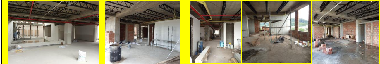
Repellos, estucos, red hidrosanitaria, red contra incendios. 6to piso.
