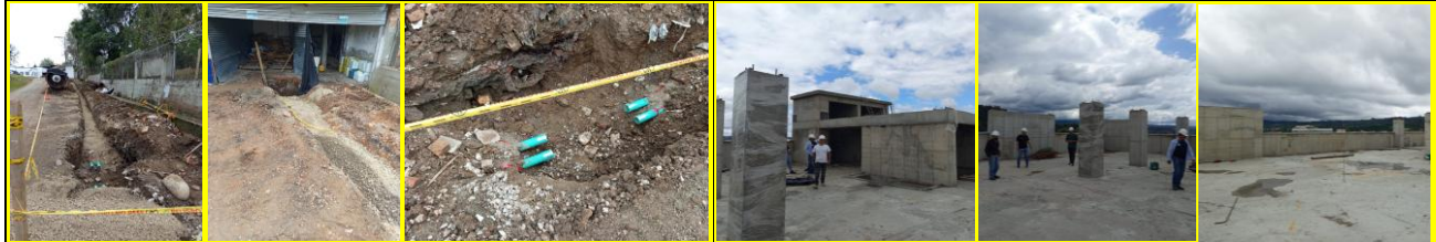
Inicio de obras de acometida eléctrica a media tensión del operador CEO.
