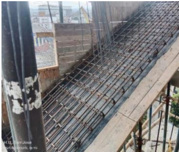
ACERO CORRUGADO F_y=420 Mpa GRADAS CENTRALES
