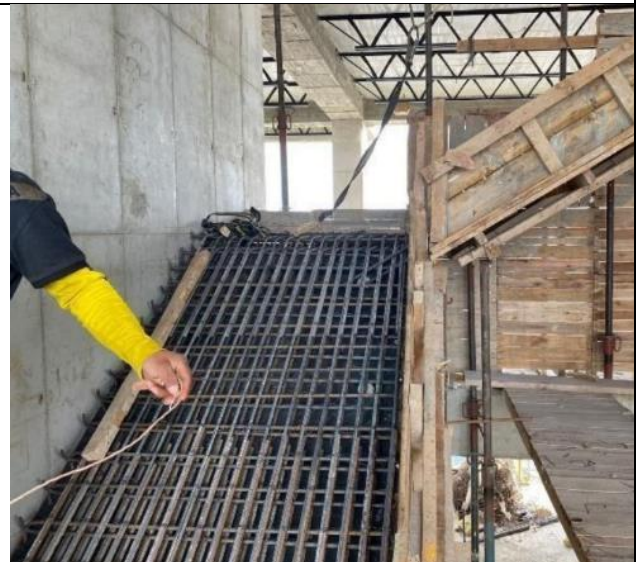
ACERO CORRUGADO F_y=420 Mpa GRADAS CENTRALES
