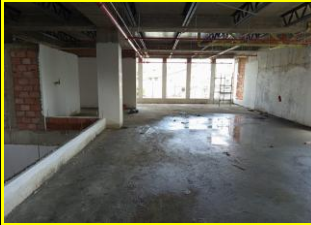
Repellos, estucos, red hidrosanitaria, red contra incendios. 3er piso.
