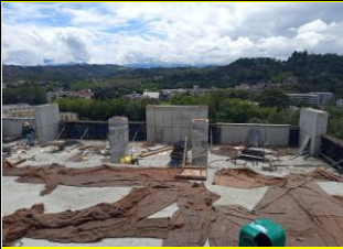
Antepecho perimetral del último piso y estructura sobre la cubierta 10mo piso.
