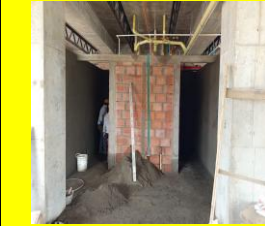
Repellos, red hidrosanitaria, red contra incendios. 5to piso.
