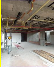
Repellos, estucos, red hidrosanitaria, red contra incendios. 2do piso.
