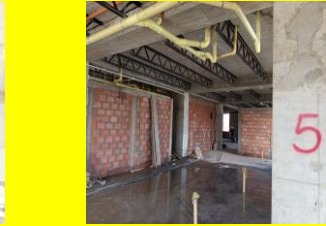
Repellos, red hidrosanitaria, red contra incendios. 5to piso.
