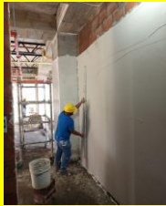
Repellos, estucos, red hidrosanitaria, red contra incendios. 4to piso.
