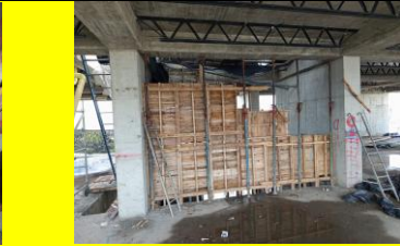
Repellos en zonas de escaleras y fundición de las del 9no piso
