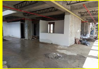
Repellos, estucos, red hidrosanitaria, red contra incendios. 3er piso.
