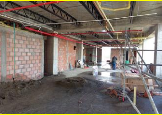
Repellos, estucos, red hidrosanitaria, red contra incendios. 6to piso.
