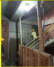
Repellos en zonas de escaleras y fundición de las del 9no piso
