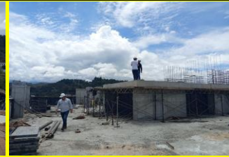
Antepecho perimetral del último piso y estructura sobre la cubierta 10mo piso.
