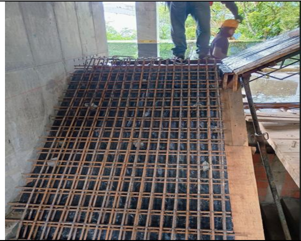
ACERO CORRUGADO F_y=420 Mpa GRADAS DE EMERGENCIA
