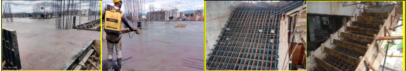
Fundición losa entrepiso N+27.10
