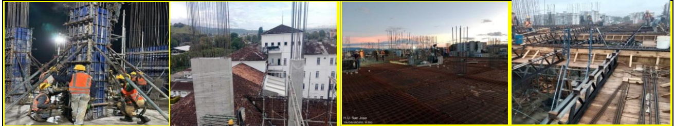
Fundición pantallas y columnas N +23.20 a N +27.10
