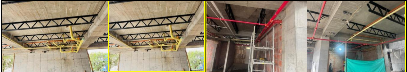
Instalacion redes hidrosanitarias
