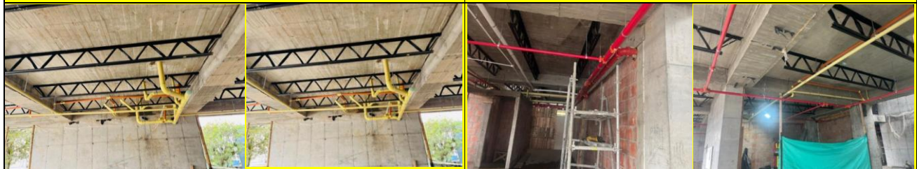
Instalacion redes hidrosanitarias
