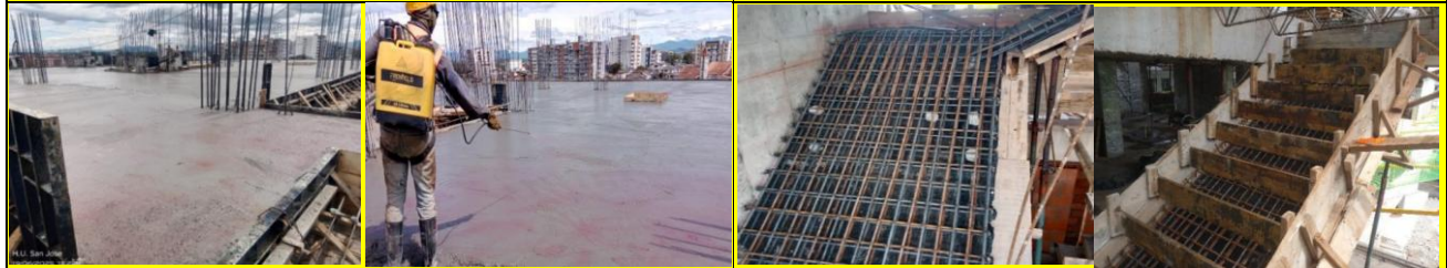
Fundición losa entrepiso N+23.20
