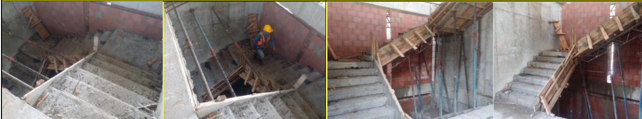
Escaleras de emergencia
