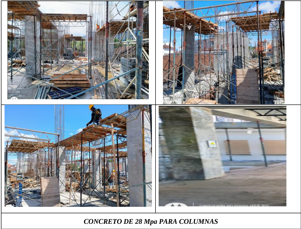
Ilustración 52. Concreto para columnas
