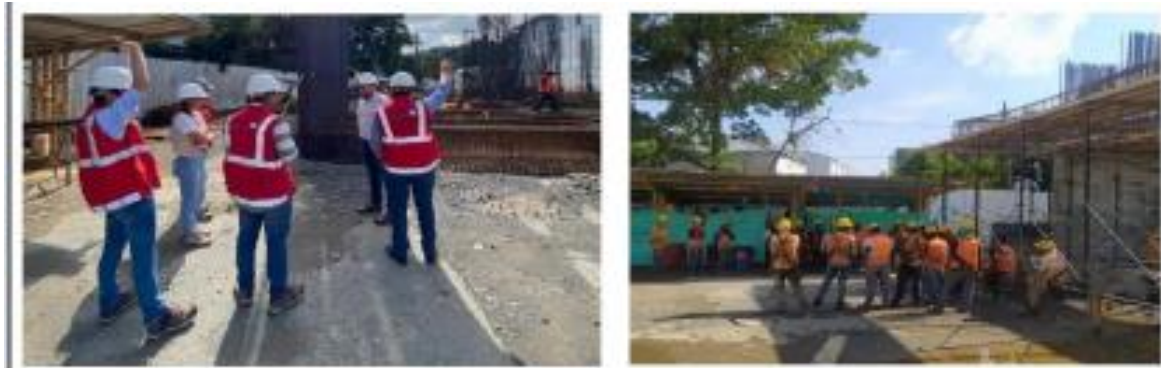
Personal en obra con indumentaria y EE.PP
