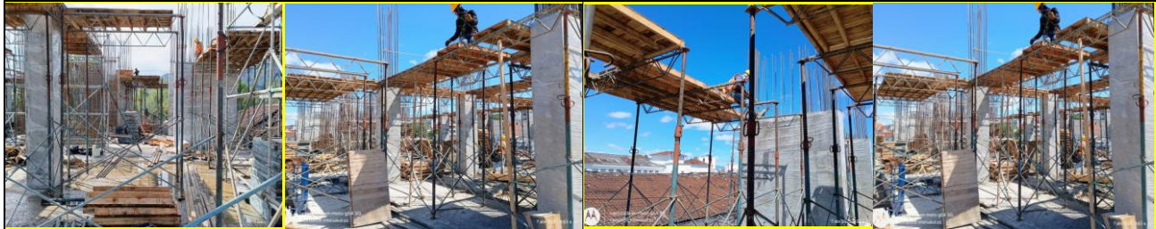
Fundición pantallas y columnas N +11.50 a N +15.40
