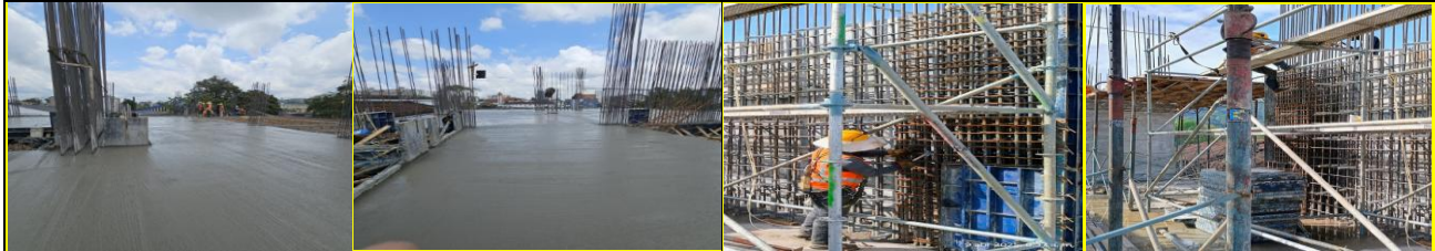
Armado de aceros para pantallas y columnas N +11.50 a N +15.40
