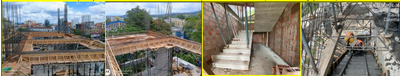
Armado de acero vigas y losa de entrepiso 4 N +15.40- Instalacion de vigas joists
