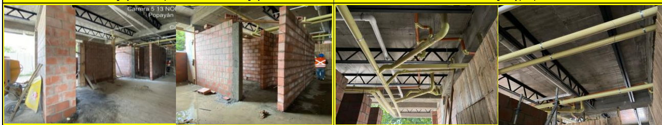
Mampostería nivel I
