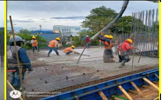
Fundición losa entrepiso N +11.50
