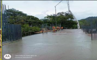
Fundición losa entrepiso N +11.50
