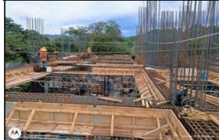
Armado de acero vigas y losa de entrepiso 3 N +11.50- Instalacion de vigas joists
