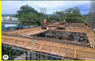
Armado de acero vigas y losa de entrepiso 3 N +11.50- Instalacion de vigas joists
