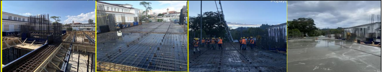
Armado de acero vigas y losa de entrespiso - Instalacion de vigas joists
