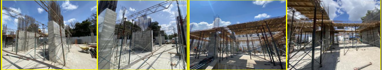
Fundicion pantallas y columnas
