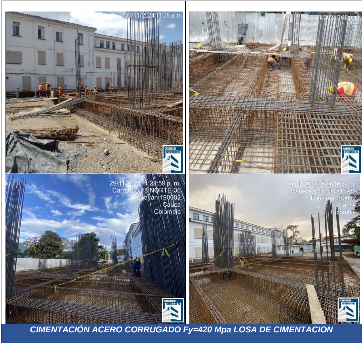
Ilustración 33. Cimentación acero corrugado losa
