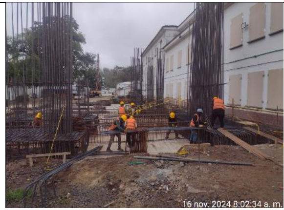
Ilustración 34. Cimentación acero corrugado Pantallas
