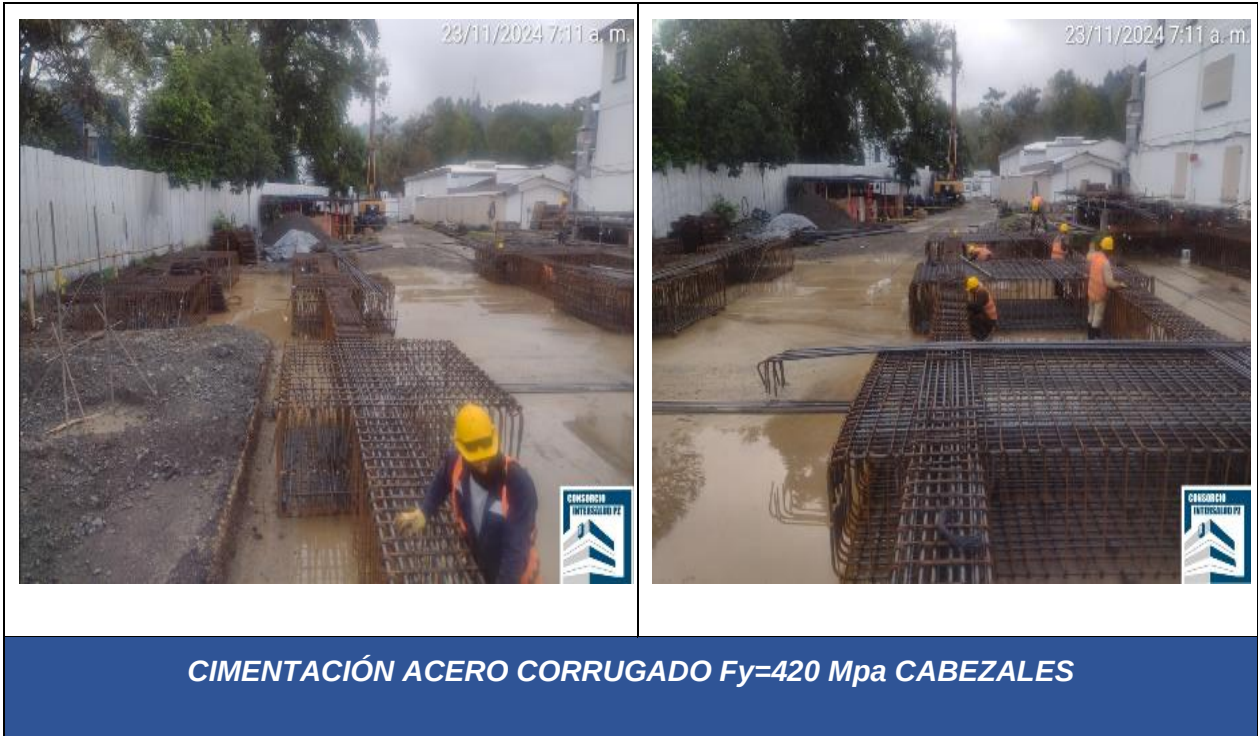
Ilustración 32. Cimentación Acero corrugado Cabezales
