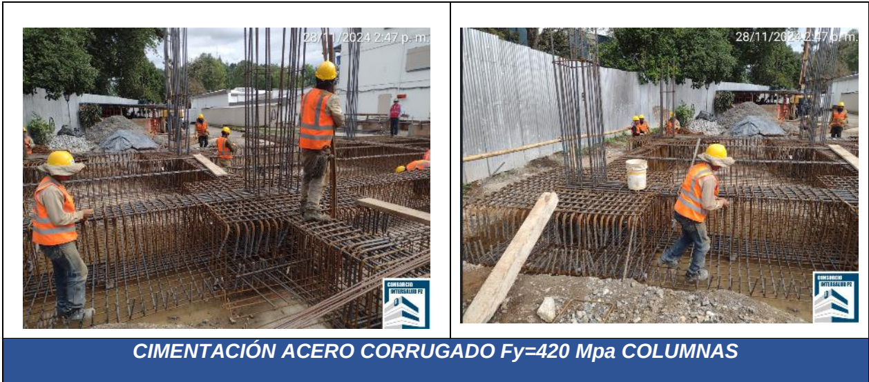
Ilustración 35. Cimentación acero corrugado Columnas
