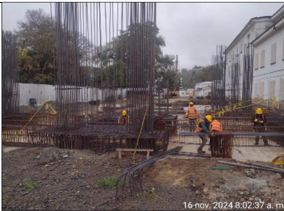
Ilustración 34. Cimentación acero corrugado Pantallas
