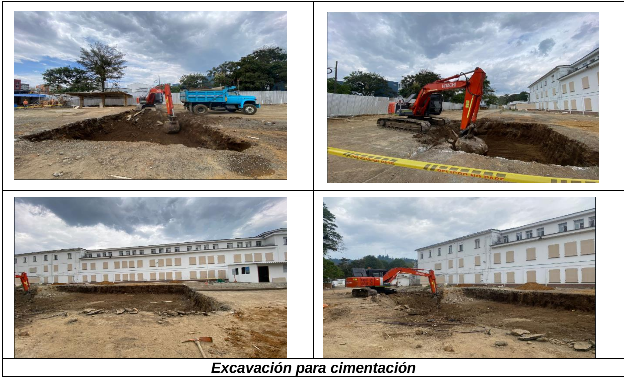
Ilustración 3. Excavación para cimentación
