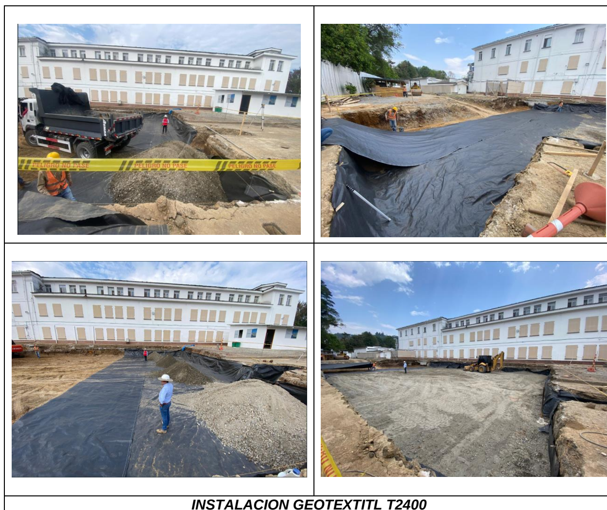
Ilustración 5. Instalación geotextil T2400
