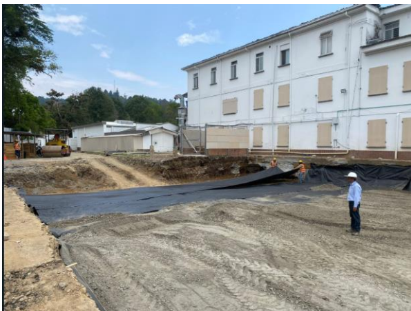
Ilustración 4. Área instalación geotextil T2400
