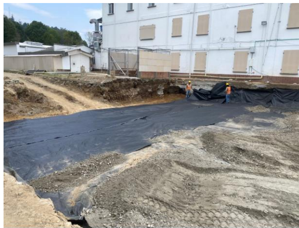
Ilustración 4. Área instalación geotextil T2400
