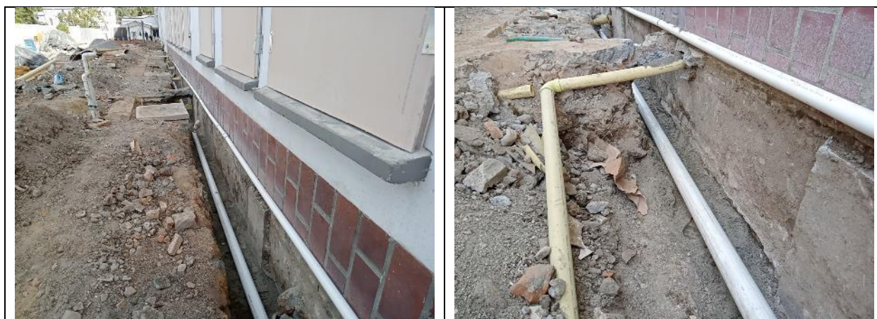
Instalacion de nueva tuberia PVC presion 3" RDE 21 al costado del edificio del hospital San Jose
