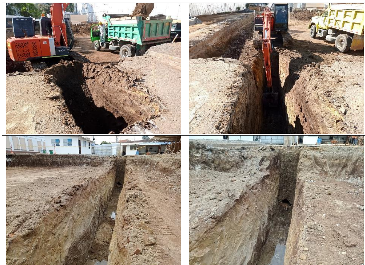
Excavaciones para retiro de tubería de Grees 21"
