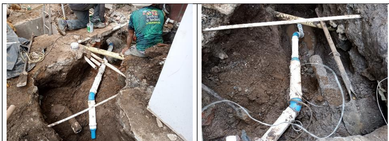
Instalacion de tuberias y accesorios de conexon para darle el recorrido y pocision a la tuberia hidraulica PVC de 3".
