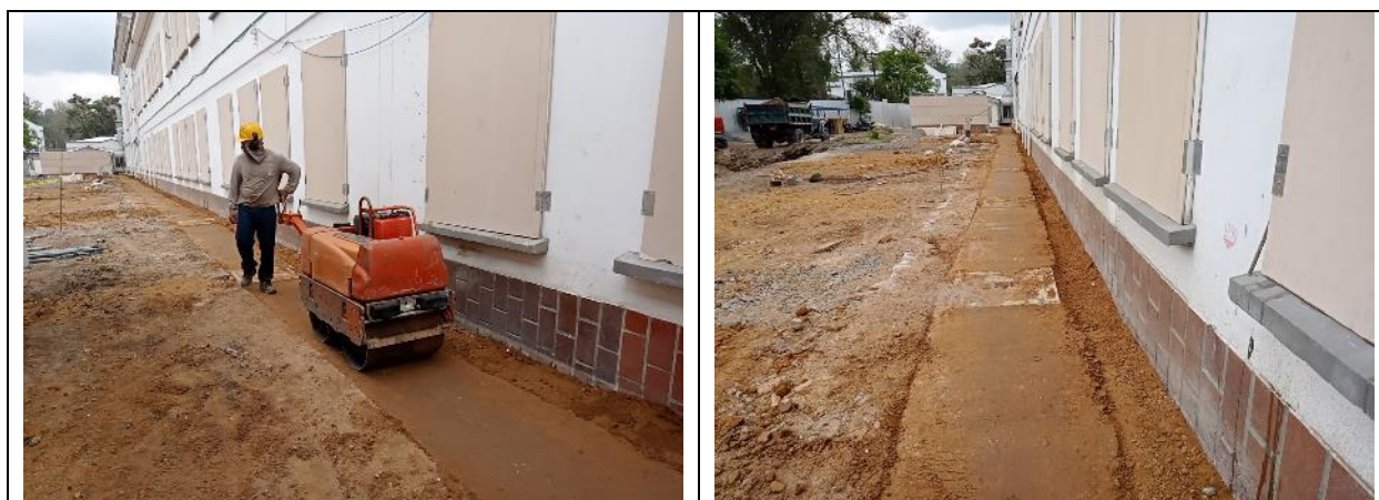
Rellenos compactados mecánicamente para red de alcantarillado sanitario nuevo
