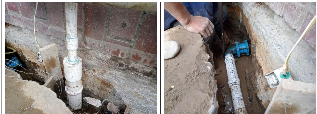
Instalacion de puntos y elementos de conexion
