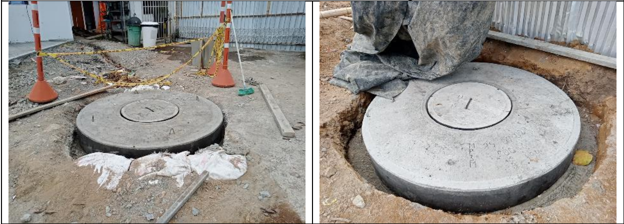
Instalacion de brocales
