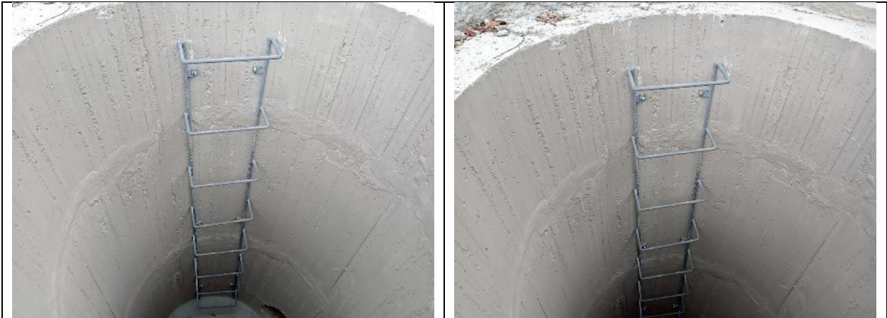
Instalacion escalerilla en varilla corrugada 5/8"
