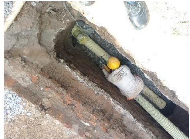
Instalacion de silla Yee 6X8 para conexion de tubería 6" y tubería recolectora 6" desde caja de inspeccion
