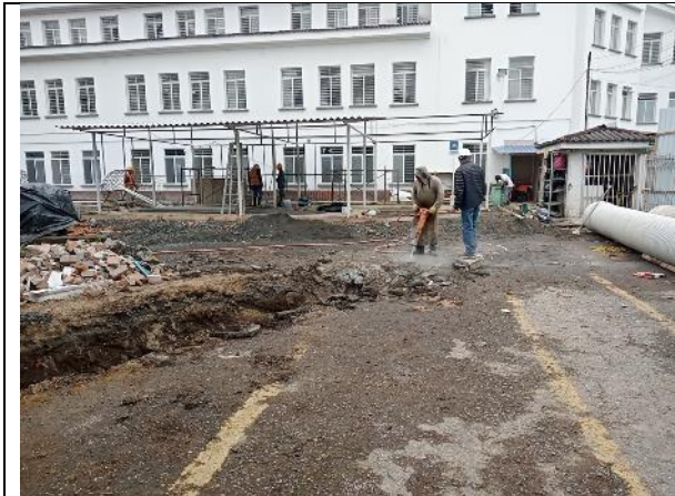
Demoliciones de placa de concreto para excavaciones de red pluvial
