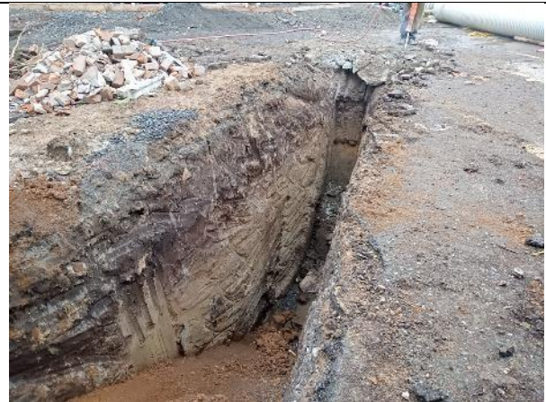
Demoliciones de placa de concreto para excavaciones de red pluvial
