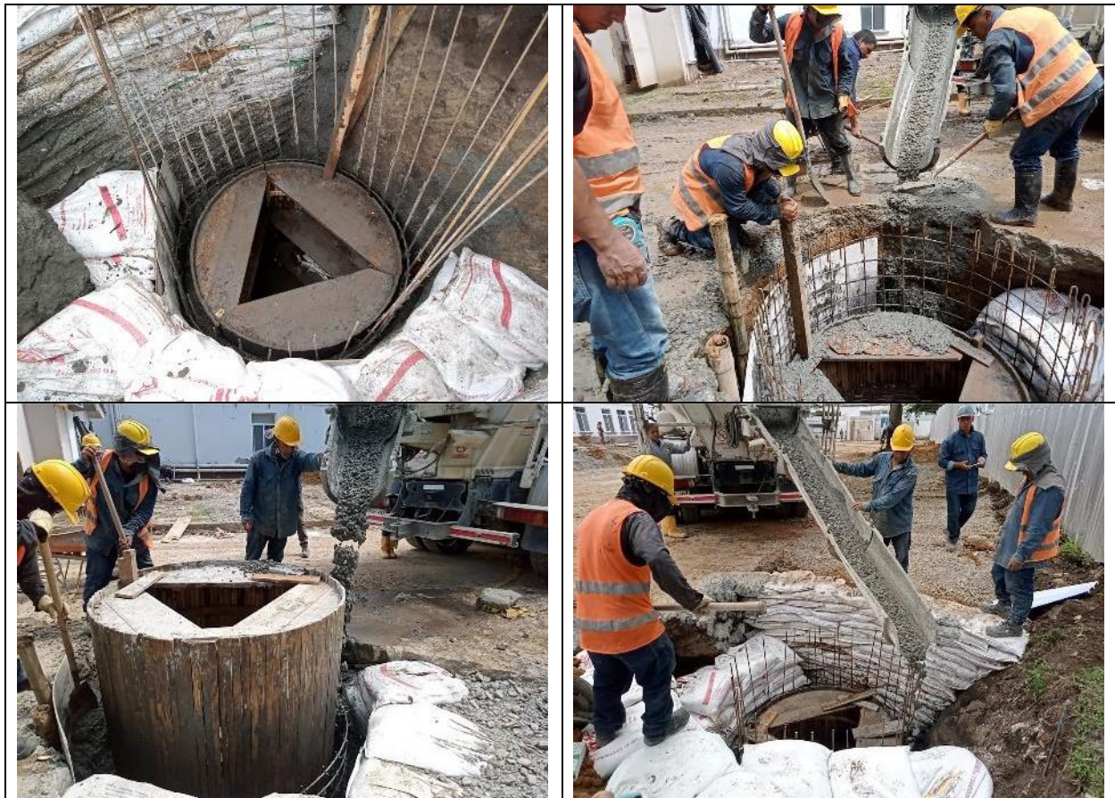
Fundición de recamaras pluviales con concreto premezclado
