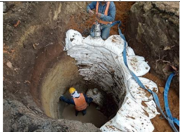
Excavacion para red pluvial y retiro de material de excavacion no apto para rellenos
