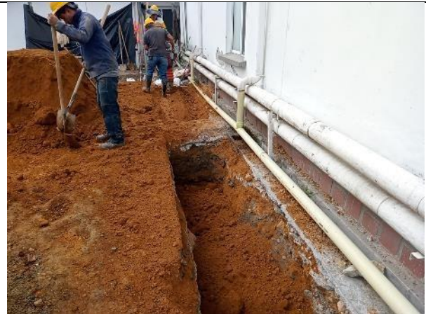
Rellenos de zanjas con material tipo limo arcilloso
