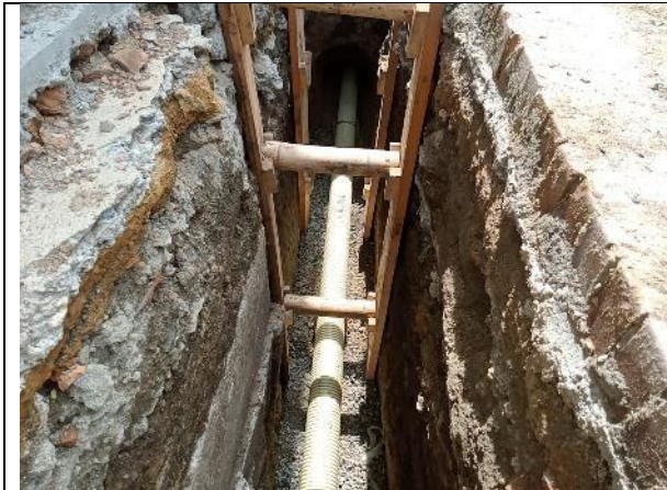
Tubería sanitaria 8" para nueva red sanitaria
