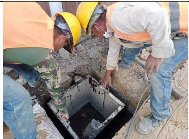
Fundicion de recamaras para red de alcantarillado sanitario nuevo
