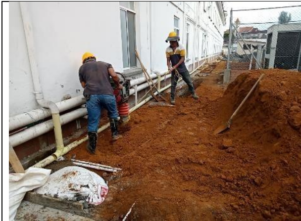
Rellenos de zanjas con material tipo limo arcilloso
