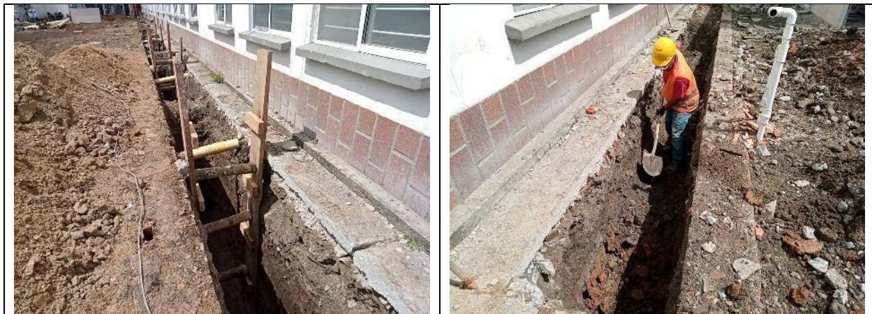
Excavaciones a mano para redes de alcantarillado sanitario
