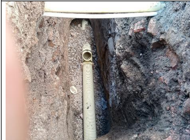
Instalacion de silla Yee 6X8 para conexion de tubería 6" y tubería recolectora 6" desde caja de inspeccion
