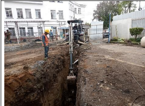
Excavacion para red pluvial y retiro de material de excavacion no apto para rellenos
