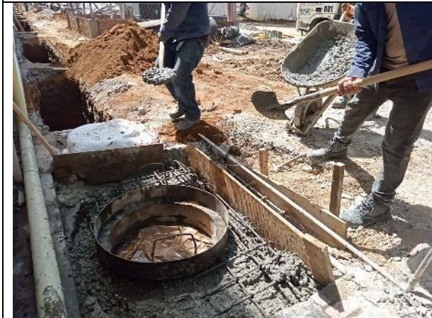
Fundicion de recamaras para red de alcantarillado sanitario nuevo
