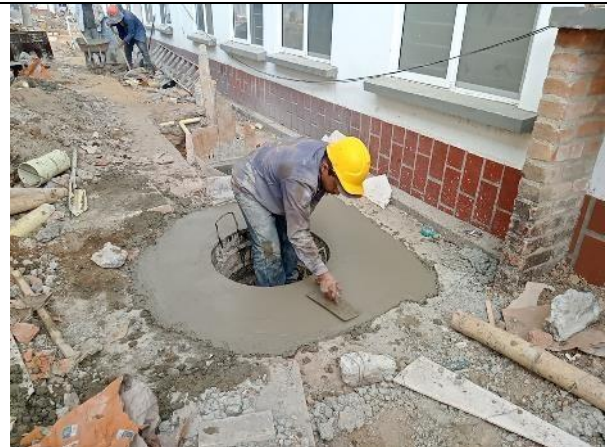
Fundicion de recamaras para red de alcantarillado sanitario nuevo
