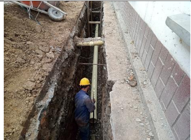
Tubería sanitaria 8" para nueva red sanitaria
