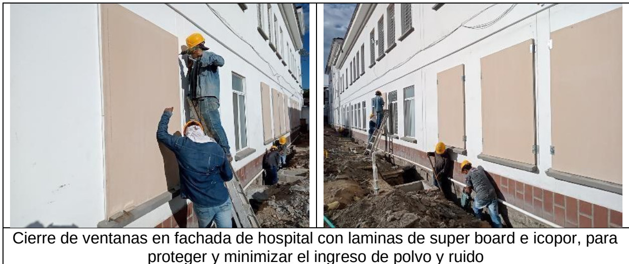
Ilustración 7. Cerramiento y protección de ventanas
