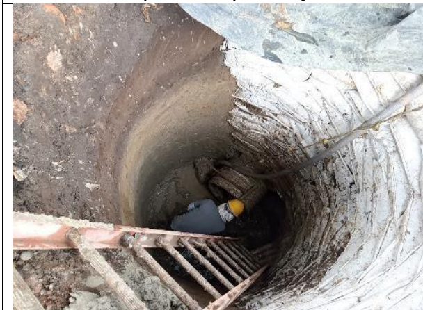
Excavacion para red pluvial y retiro de material de excavacion no apto para rellenos
