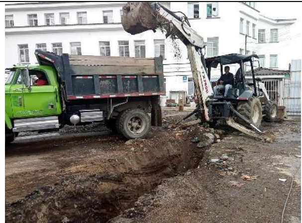
Excavacion para red pluvial y retiro de material de excavacion no apto para rellenos
