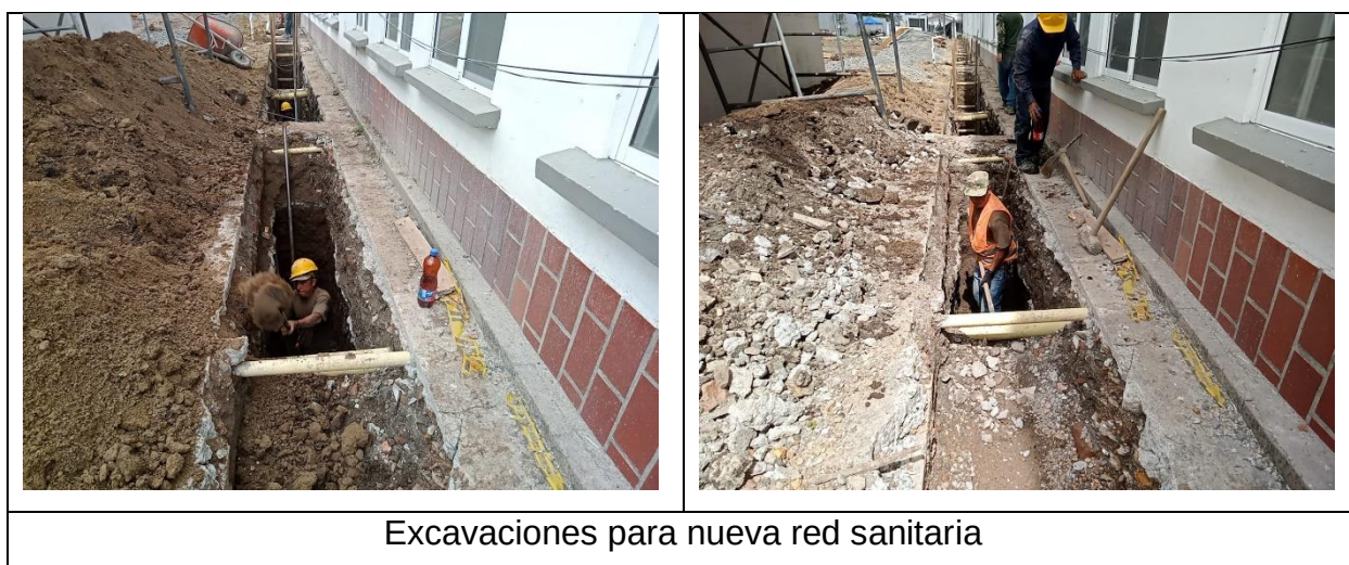
Ilustración 10. Excavación red sanitaria
