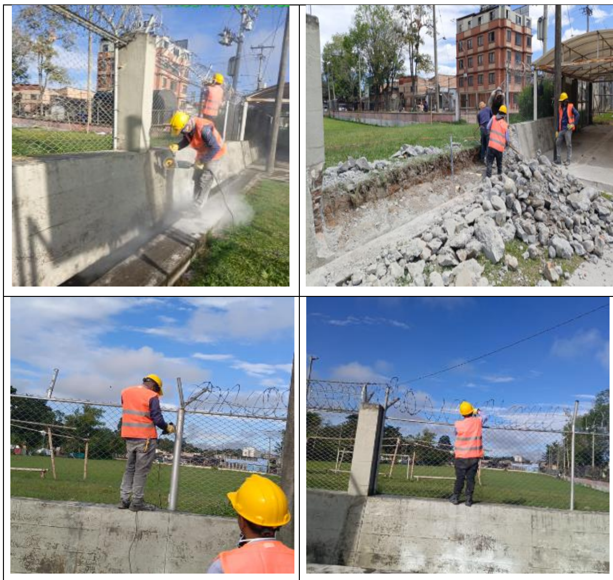
Ilustración 2. Adecuación entrada posterior. Muro concreto ciclópeo
