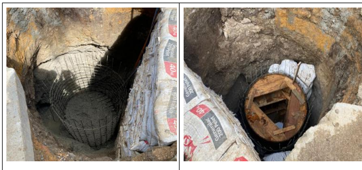
Ilustración 9. Armado de acero y encofrado de recamaras
