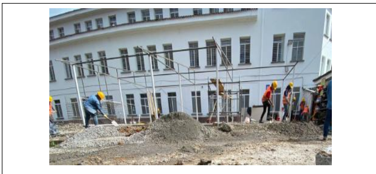
Ilustración 11. Inicio de construcción de campamento de obra
