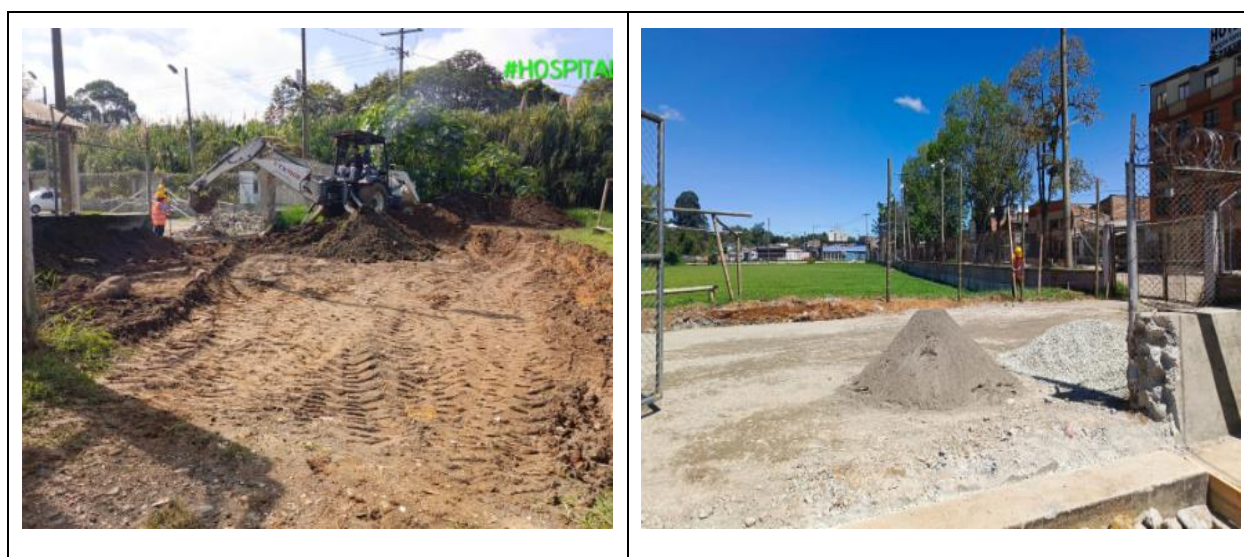
Ilustración 3. Nivelación y mejoramiento vía de entrada.
