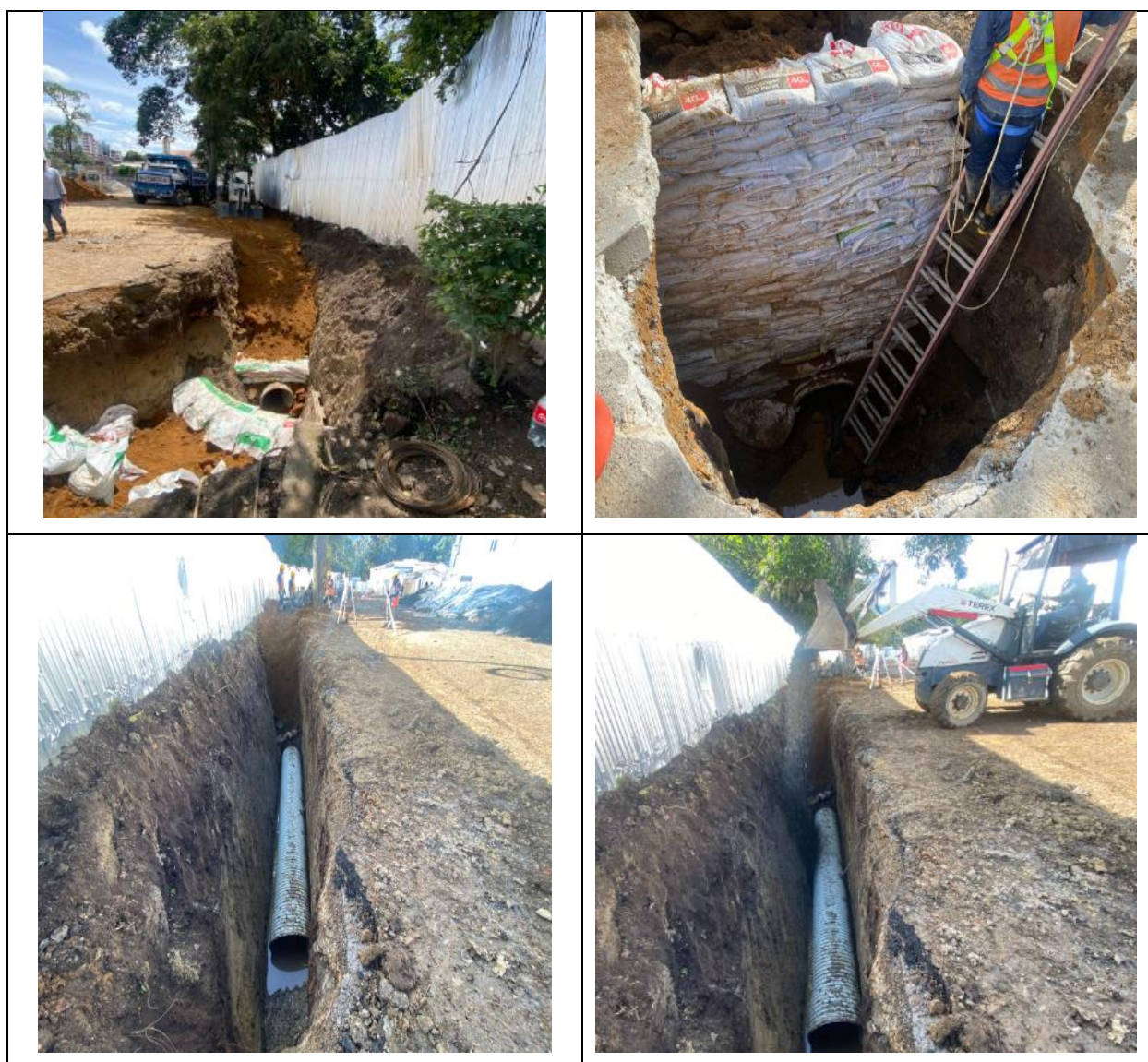
Ilustración 8. Excavación e Instalación alcantarillado pluvial
