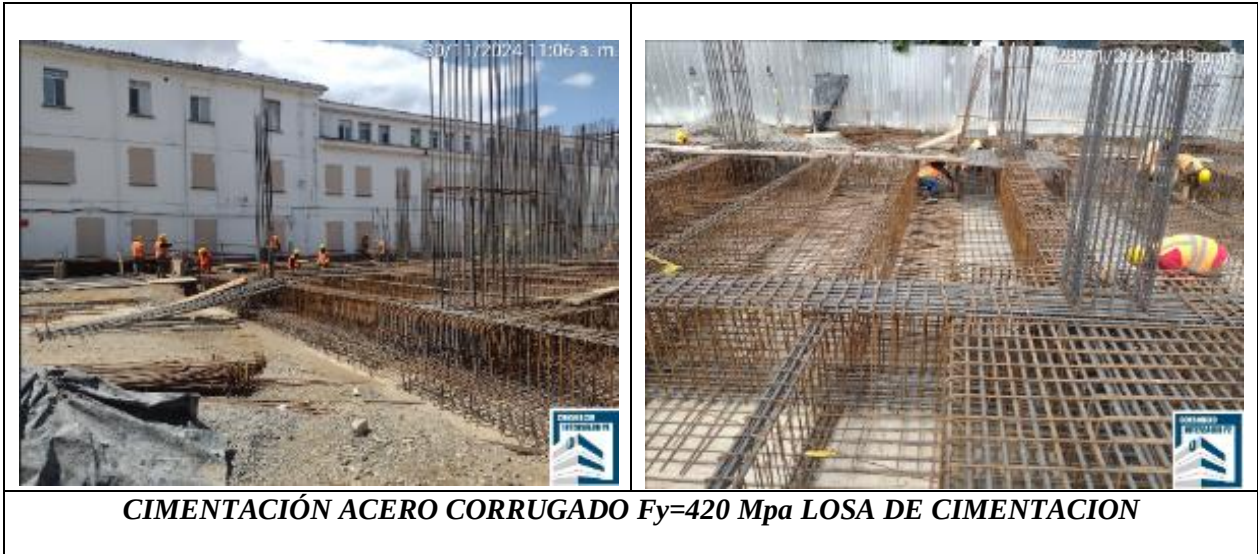
Ilustración 21. Acero corrugado losa de cimentación
