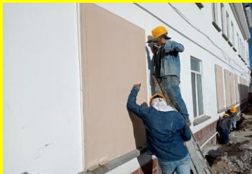
CERRAMIENTO DE VENTANAS DE FACHADA HOSPITAL
