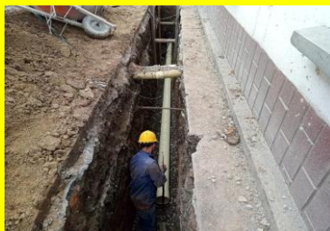
INSTALACION TUBERIA SANITARIA 8"
