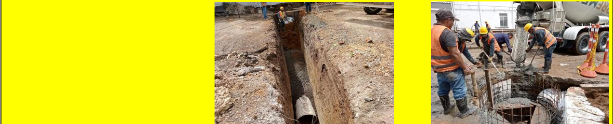
INSTALACION DE TUBERIA PLUVIAL 27" FUNDICION DE RECAMARAS
