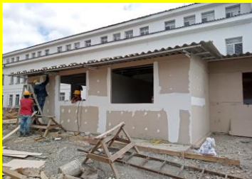
CONSTRUCCION DE CAMPAMENTO
