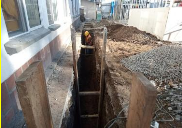
EXCAVACION PARA ALCANTARILLADO SANITARIO
