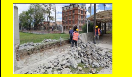
ADECUACION DE ACCESO ZONA POSTERIOR DEL HOSPITAL
