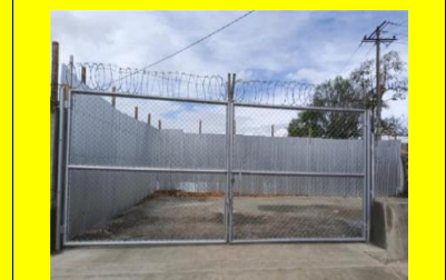
ADECUACION DE ACCESO ZONA POSTERIOR DEL HOSPITAL
