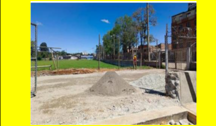
ADECUACION DE ACCESO ZONA POSTERIOR DEL HOSPITAL
